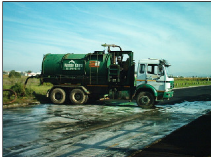
Un aspirador eleva a la Cisterna del camión el aceite de palma y los efluentes desengrasantes.
