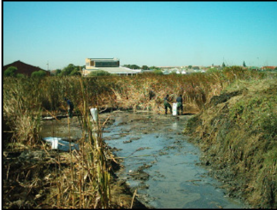
Extendiendo Biomatrix al área contaminada absorbe cualquier residuo de aceite.
