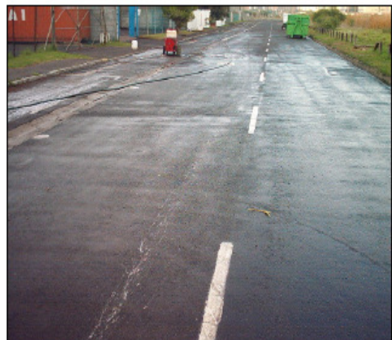
Alta presión que lava la superficie del asfalto.
