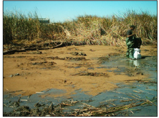
Extendiendo Biomatrix al área contaminada absorbe cualquier residuo de aceite.
