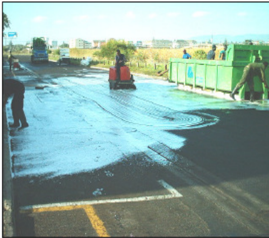
Alta presión que lava la superficie del asfalto.
