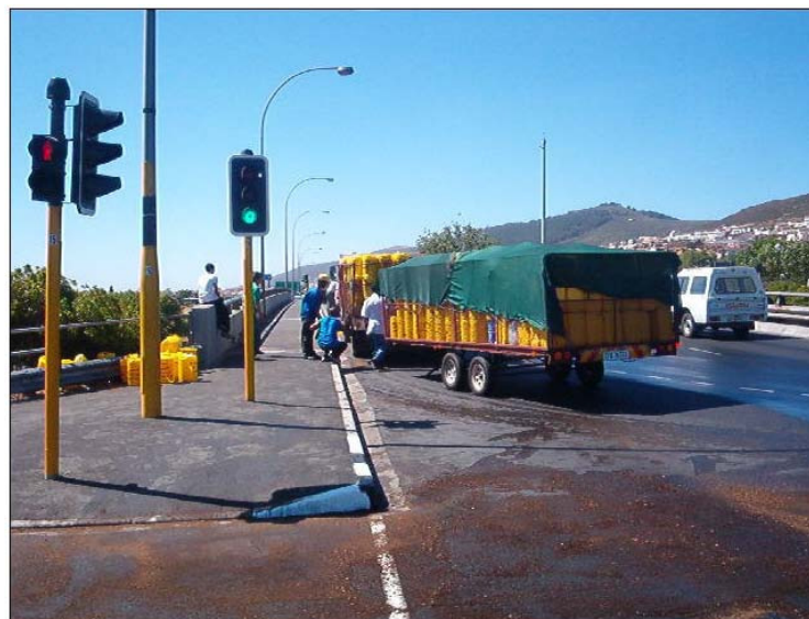
Encharcamiento de diesel en el borde del asfalto junto al bordillo.
