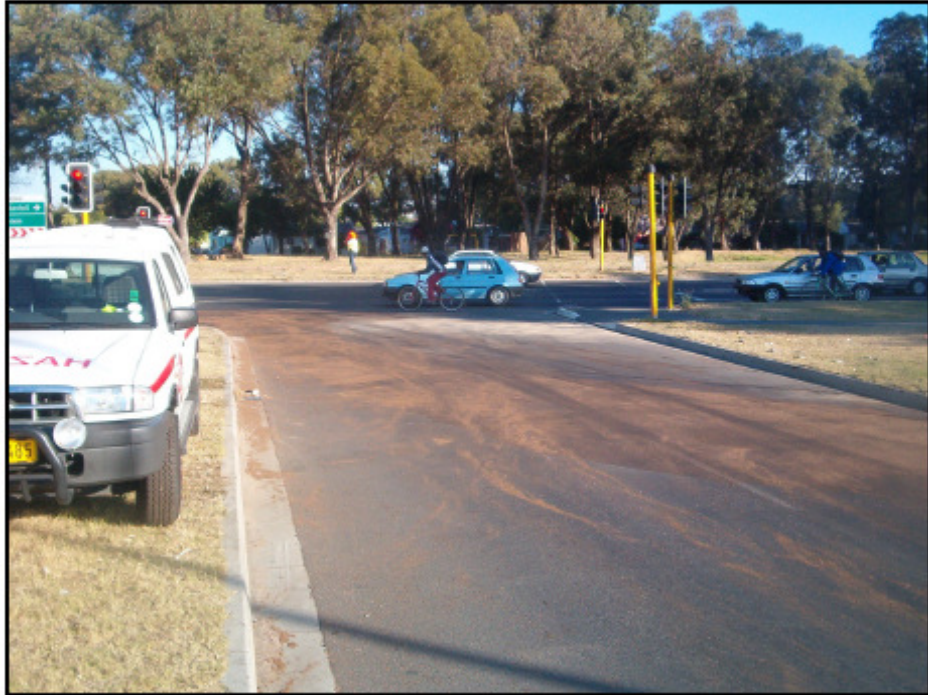
Capa final de biomatrix gold echado en la calzada para absorber los restos de diesel.
